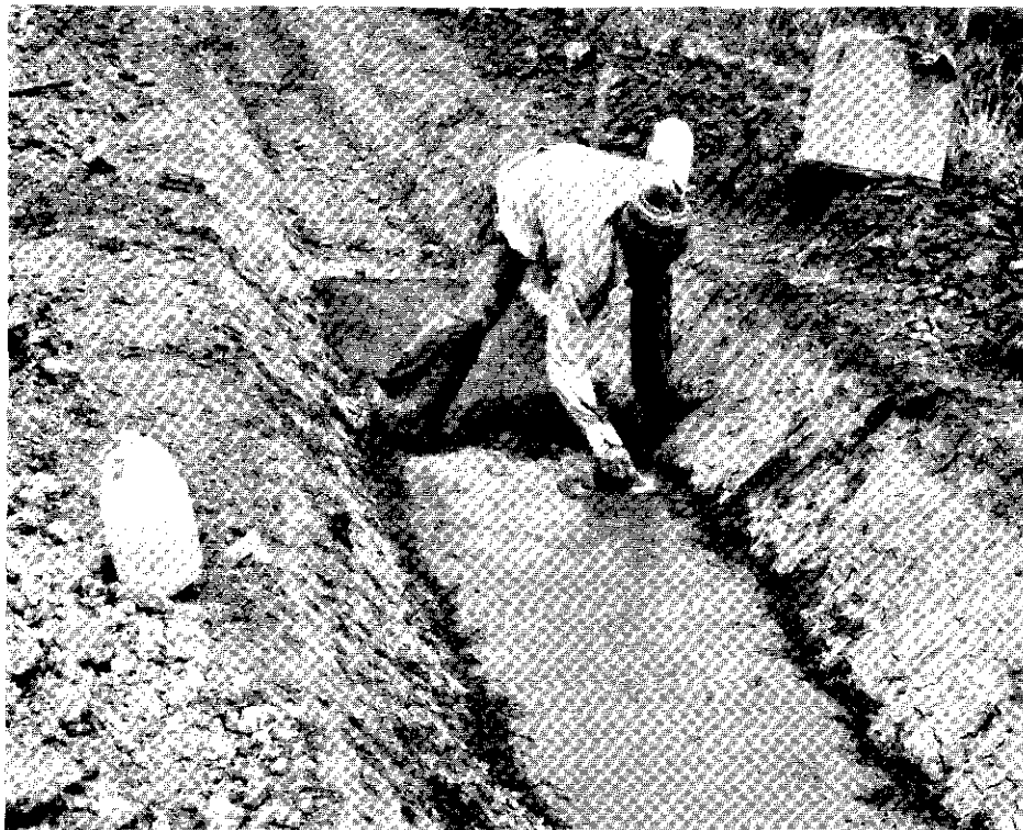
Figura 8. La fotografía ilustra la labor de fundición del piso del canal, la cual se hace en tramos de tres metros, separados por tablas de otobo con un espesor igual al de la capa de revestimiento.
