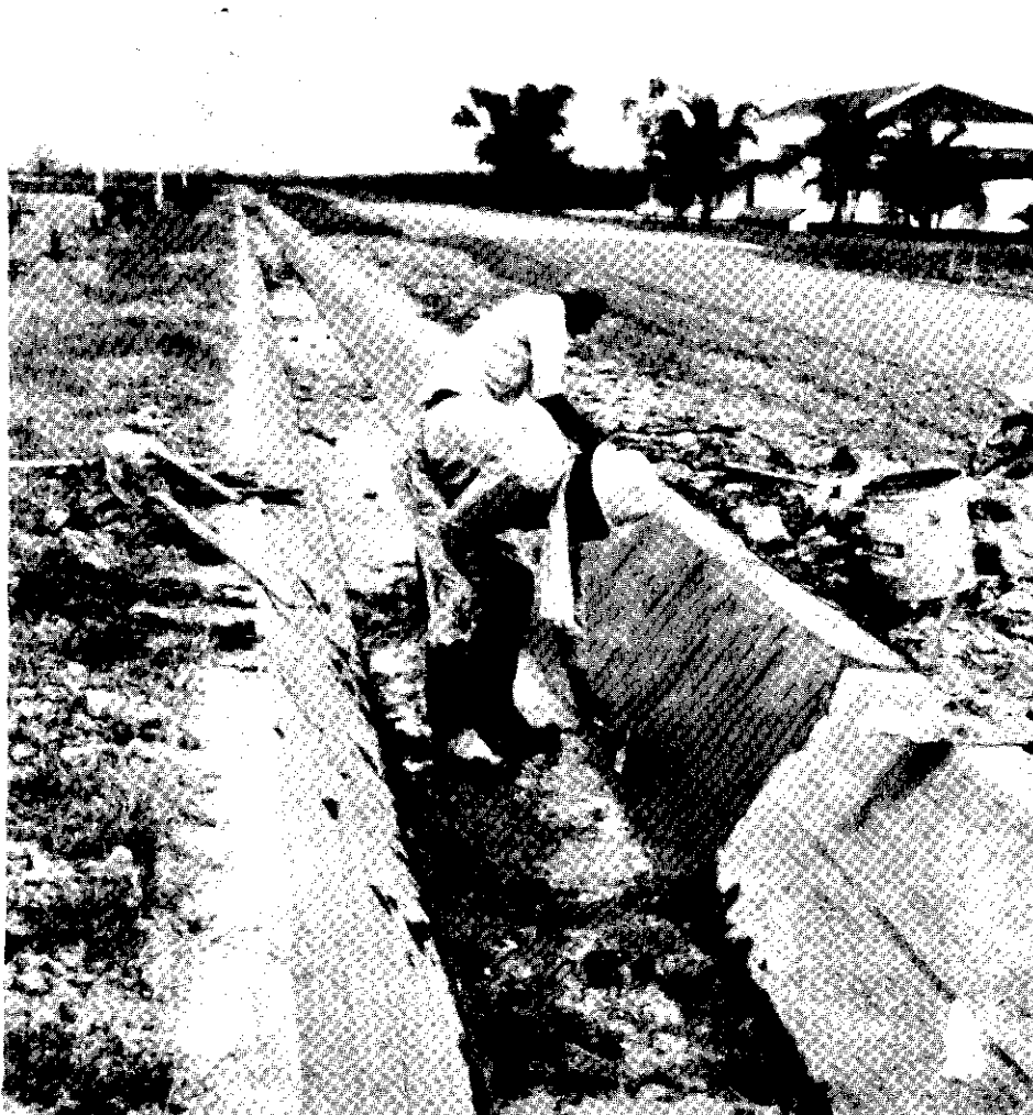
Figura 10. La fotografía muestra la labor de alisado e impermeabilización de la capa de revestimiento de las paredes del canal.
