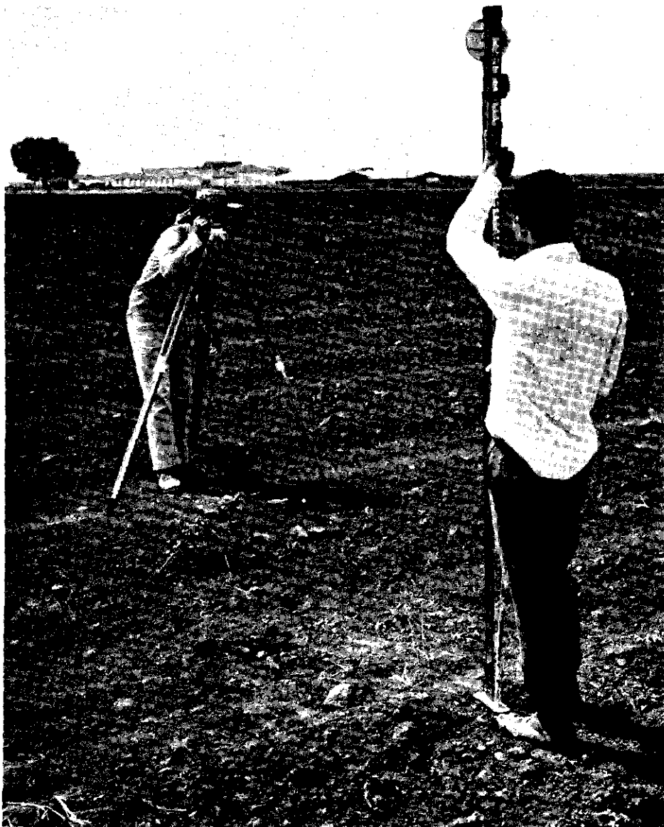
Figura 3. La nivelación de un terreno sin rastrojos ni malezas, y aún previamente rastrillado, no sólo facilita la labor de los topógrafos, sino que se obtienen datos más precisos, lo cual es muy importante en terrenos planos (pendientes <1\% ), como los que ilustra la fotografía de un terreno en la sede del CIAT en Palmira.
