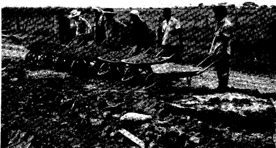
Figura 2. En la sede del CIAT (Palmira) se encontró un suelo franco-arenoso (aproximadamente 73% de arena y 14% de arcilla) que sirve para el propósito de este sistema de revestimiento de canales.
