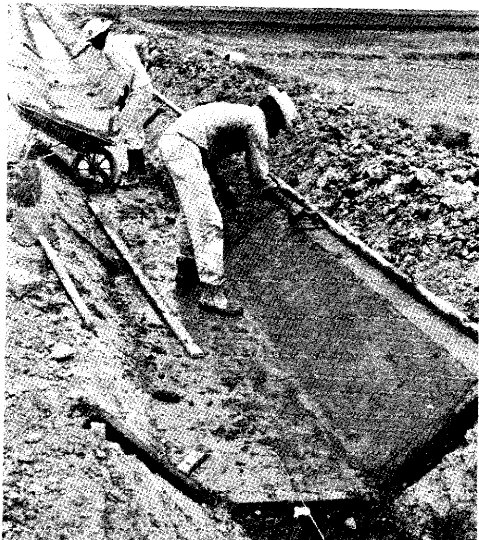
Figura 9. Al igual que el piso del canal, las paredes se funden en tramos de tres metros, separados por tablillas colocadas con el ángulo de inclinación escogido; en el CIAT el talud de la sección trapezoidal de los canales es de 1:1.
