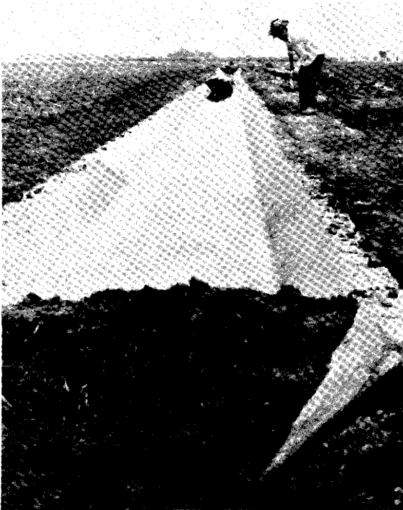
Figura 11. El endurecimiento de la mezcla de suelo-cemento se logra mediante el llenado del canal con agua durante tres semanas, lo cual asegura una mayor durabilidad de la obra.
