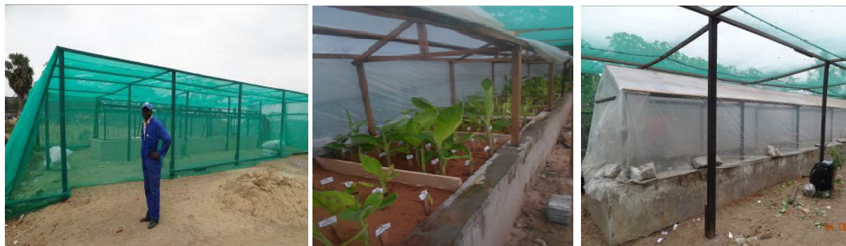
Figure 1. Construction de propagateurs et de l'ombrière
