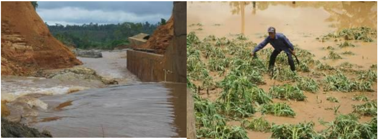
Đập thủy điện Đăk Rông 3 vỡ chỉ sau 15 ngày nghiệm thu, phát điện
