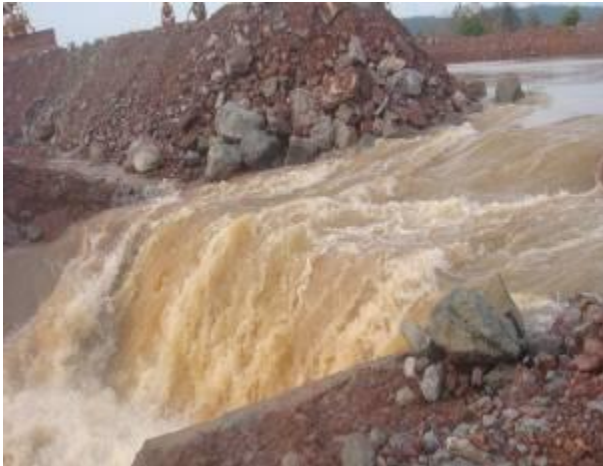
Vỡ kênh dẫn dòng thủy điện Sêrêpôk 4A
