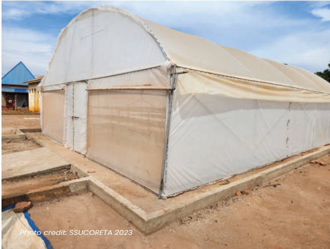
Picha Na. 10. Kaushio la muhogo la kitalu nyumba linalotumia nguvu ya jua (solar drier) linavyoonekana kwa nje
