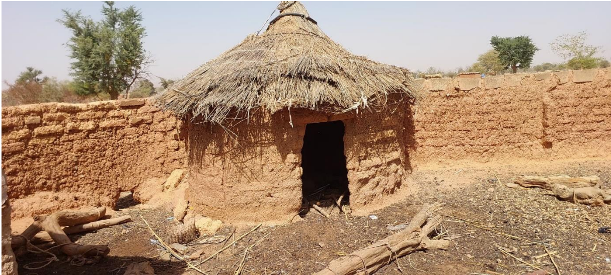
Figure 9 : Poulailler d'un ménage de la commune de Boussouma
