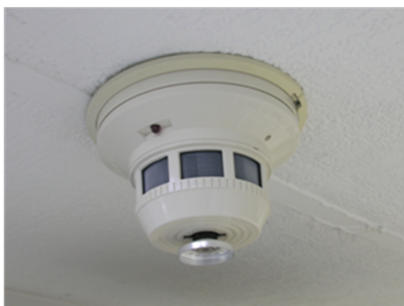
Figura 9. Sistemas de seguridad para censar presencia de humo y aumento de temperatura en los cuartos de crecimiento y conservación.
