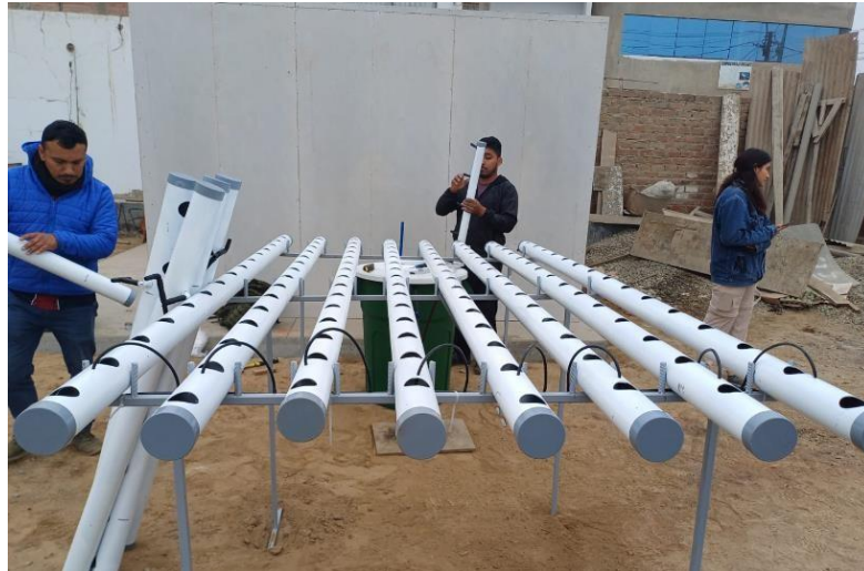
Figura 4. Instalación del sistema Hidropónico.
